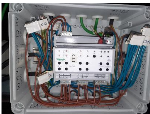
Stores - KNX - actionneur de commutation Schneider- 12x230V - 10A - à commande manuelle. Placée en plénum FP des circulations
