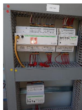
CTA 01/02/03 Toiture : Schneider Xenta 302 (régulateur) + module d'extension Xenta 422A et 452A (module extension E/S)
