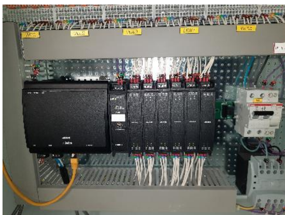
Local Transfo et TGBT sous-sol : Routeur Enteliweb contrôleur Bacnet de chez Delta Control
