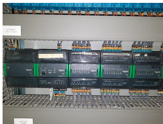
Armoire local traitement d'air sous-sol (restauration) = CTA 4 / 5 / 6 / et 8 (traitement d'air archives) et extracteurs - Schneider, automate SMART X ASP : bacnet MS/TP - Modbus
