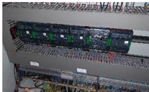
Chaufferie (production chauffage et ecs) : Automate SMART X ASP Schneider, bacnet MS/TP - Modbus
