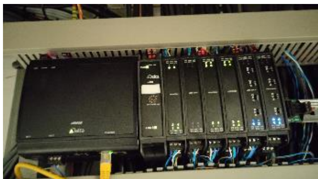
AD : Routeur/contrôleur Enteliweb de Delta Control, Bacnet
