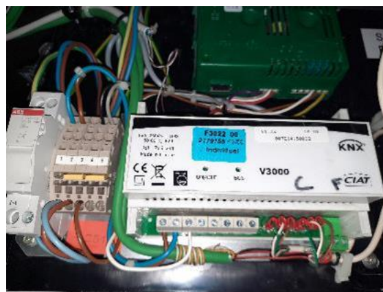
Ventilo convecteurs : Régulateur Ciat V3000 propriétaire KNX
