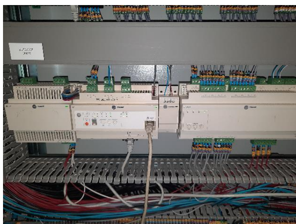
Armoire local traitement d'air sous-sol (restauration) - Automate GF Trane BACNET UC 600 et modules d'extension E/S XC30 : T XC32 + Passerelle Lon / modbus / Bacnet ms/TP -
