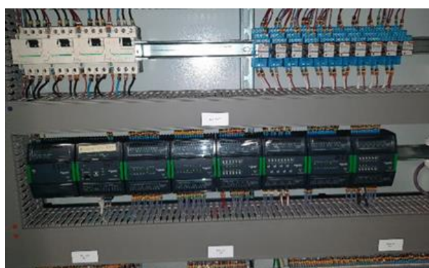
Local CVC sous-sol = CTA 7 et extracteur 9/10 (archives) : Schneider, automate bacnet MS/TP - Modbus
